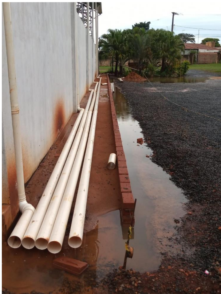
Obra para Captura e escoamento da água da quadra coberta
