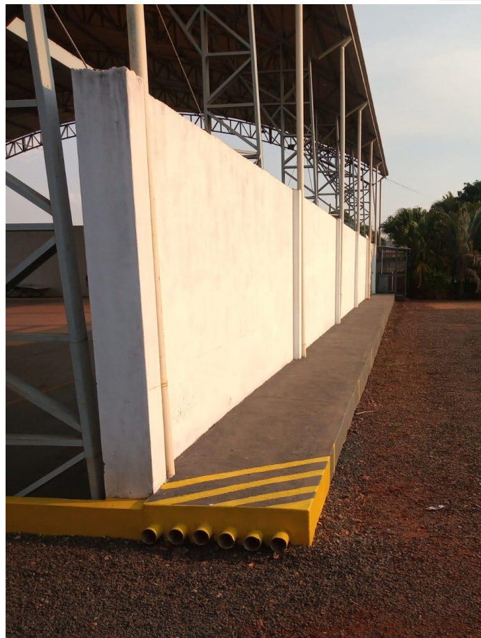
Obra para Captura e escoamento da água da quadra coberta
